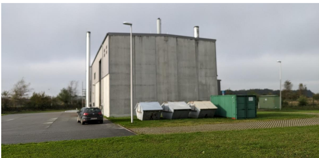
Abbildung 2: Blick auf das Heizkraftwerk (Quelle: Eigene Darstellung)
